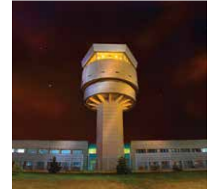
İstanbul Sabiha Gökçen Havalimanı Heaş Binası
